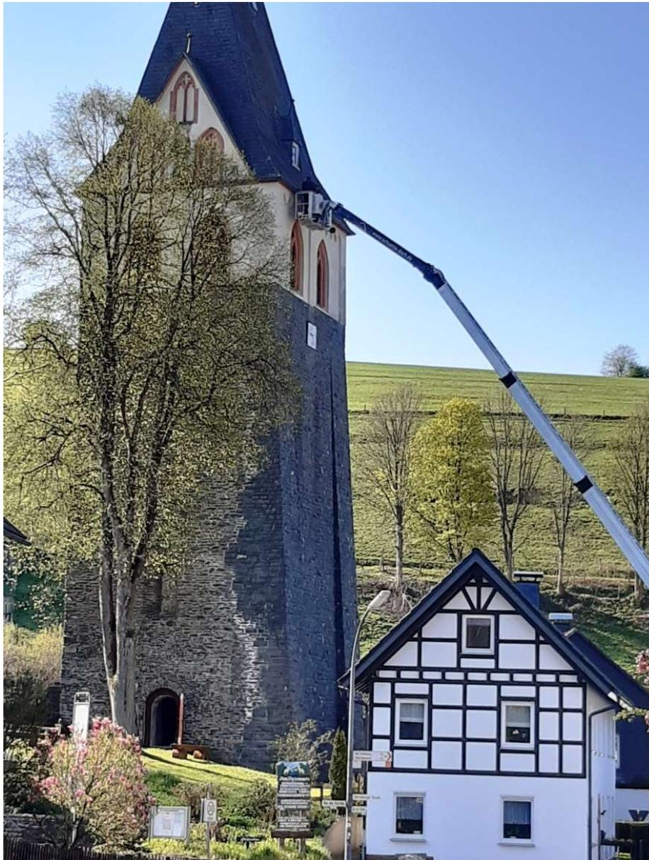
Einige Schiefersteine mussten rund um das Fenster oberhalb der Schalllöcher erneuert werden. Die Dachrinne, die eigentlich nur geflickt werden sollte, muss wahrscheinlich in absehbarer Zeit komplett erneuert werden. Auch der Zustand der Schiefersteine am Turm lässt befürchten, dass in einigen Jahren eine Neueindeckung des ganzen Daches notwendig wird. Diese Arbeiten könnten dann aber nur bei einem vollständig eingerüsteten
